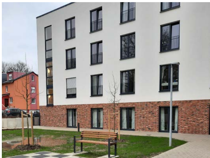
Abbildung 2: Das Haus an der Krachtstraße.
